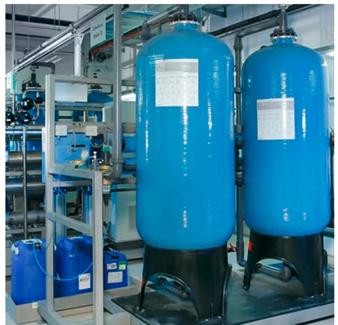
Scambio ionico per il trattamento dell'acqua di processo (ad es. acqua di alimentazione della caldaia)
