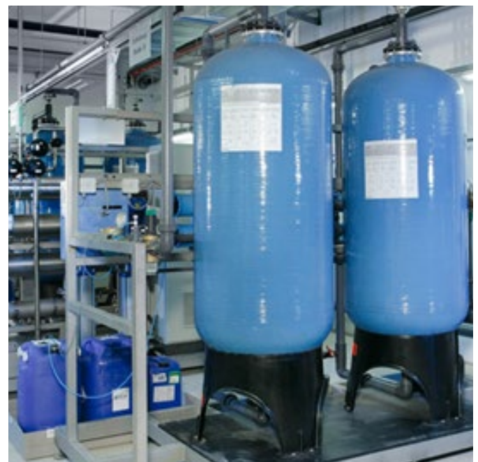
Ionenaustausch zur Aufbereitung von Prozesswasser (z.B. Kesselspeisewasser)
