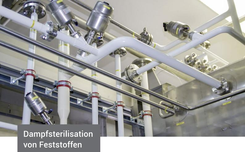
Zuverlässige und individuelle GEMÜ Ventiltechnik für die Dampfsterilisation von Werkzeugen und Komponenten.
